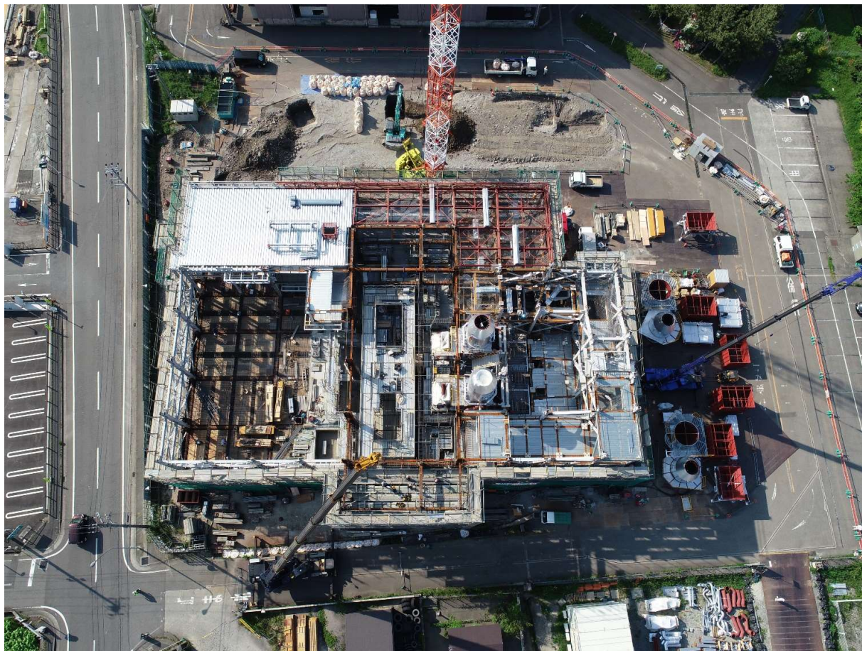
ランプウェイ部分の地盤改良中 他
