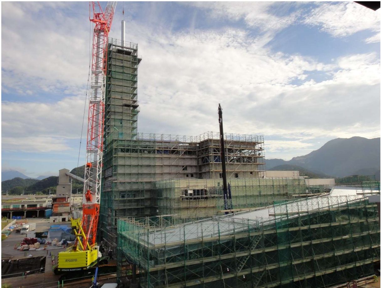
煙突内筒の据付中 他
