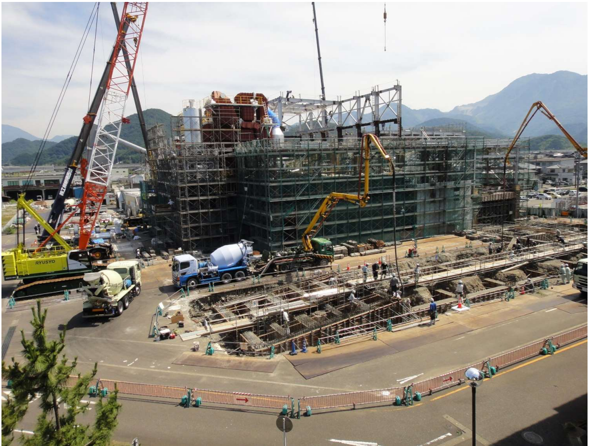
ランプウェイの基礎と地中梁のコンクリート打設中 他
