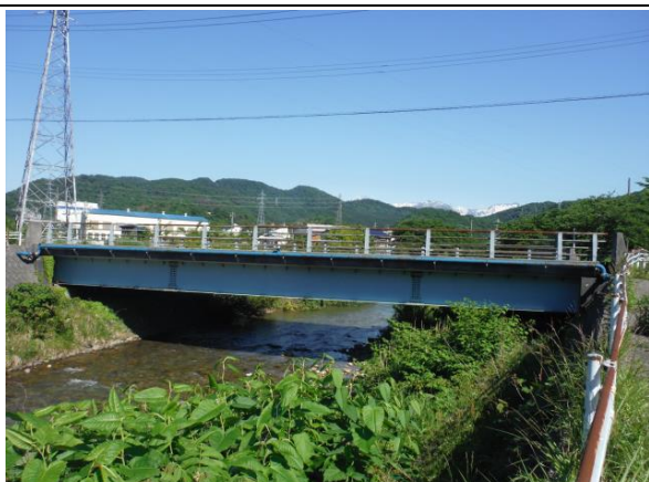
写真全景 (鋼橋)
