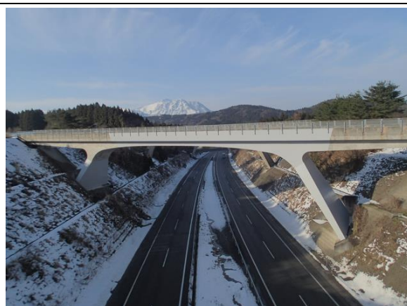
写真全景 (コンクリート橋)
