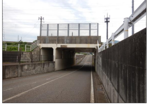
川原線地下道
