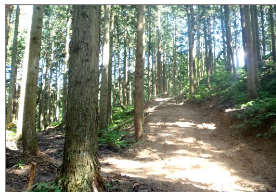
整備された作業道（大平寺地内）
